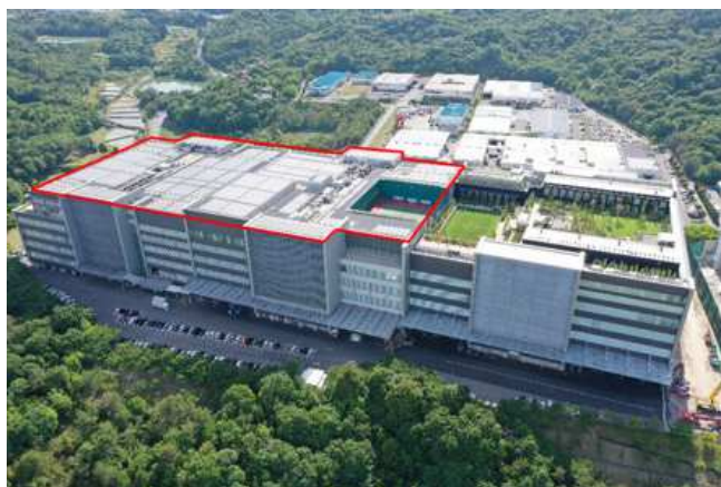
桑畑工場 太陽光発電システム
